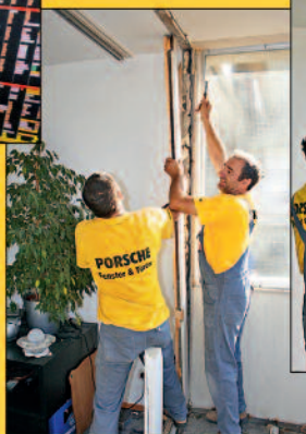
Sorgfältige Demontage, ohne das Mauerwerk zu beschädigen.
