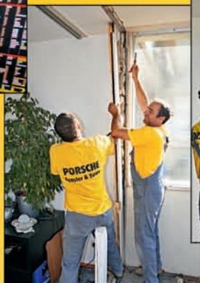
Sorgfältige Demontage, ohne das Mauerwerk zu beschädigen.
