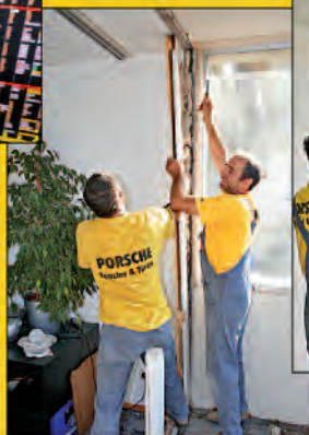
Sorgfältige Demontage, ohne das Mauerwerk zu beschädigen.
