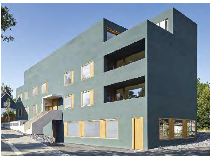
Dieser Neubau in Mainz wurde mit einem ersten Preis in der Kategorie Wohn- und Geschäftshäuser des 24. Deutschen Fassadenpreises ausgezeichnet.
