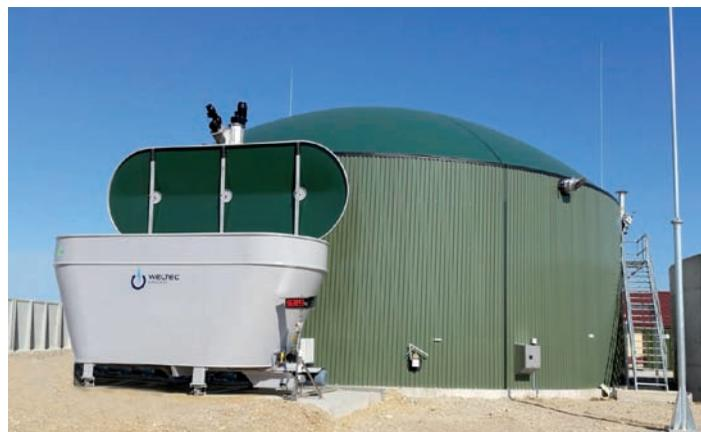
Angesichts des Gülleanteils reicht ein kleiner, 35 Kubikmeter fassender Dosierer zum Eintrag der Feststoffe, wie Maissilage, aus.
