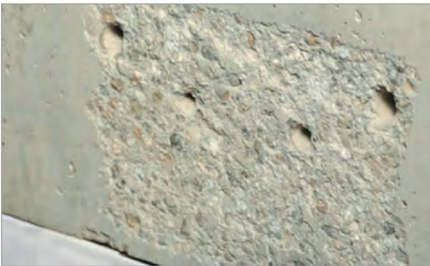
Abb. 3: Die Stirnfläche der Bestandsdecke wird komplett aufgeraut um den Verbund zu gewährleisten.
