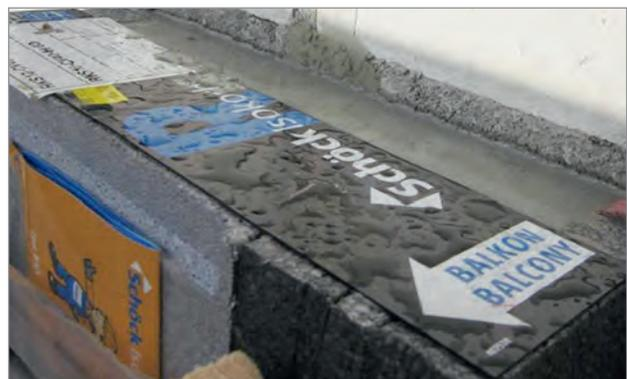
Abb. 8: Im letzten Schritt wird die Vergusstasche mit speziellem Mörtel verfüllt. Damit wird die Druckzone des Anschlusses kraftschlüssig mit der Decke verbunden.
