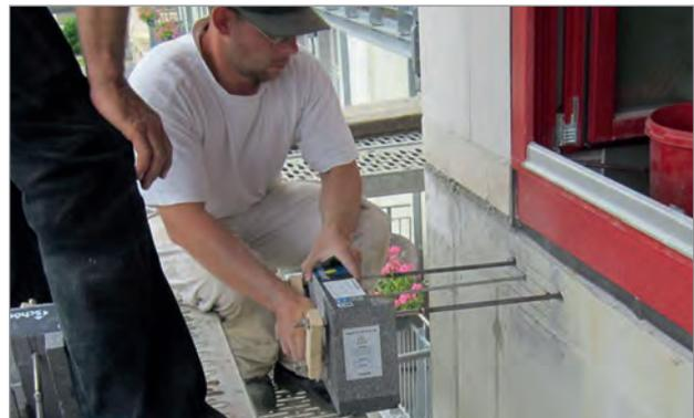
Abb. 6: Der Isokorb® R wird von außen in die Bestandsdecke eingeschoben.
