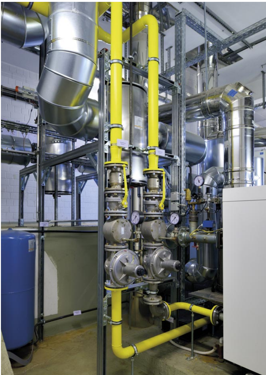
Der Gas-Brennwertkessel ist der emissionsärmste seiner Art am Markt und erfüllt bereits heute alle Anforderungen der NOx-Klasse 6.
