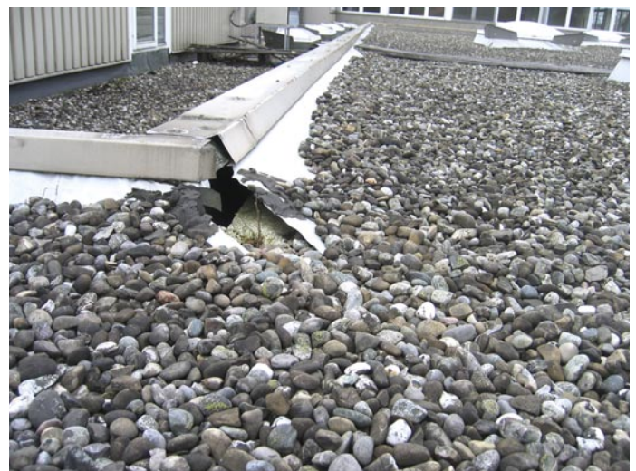
Dachbahn im Anschlussbereich aufgerissen
