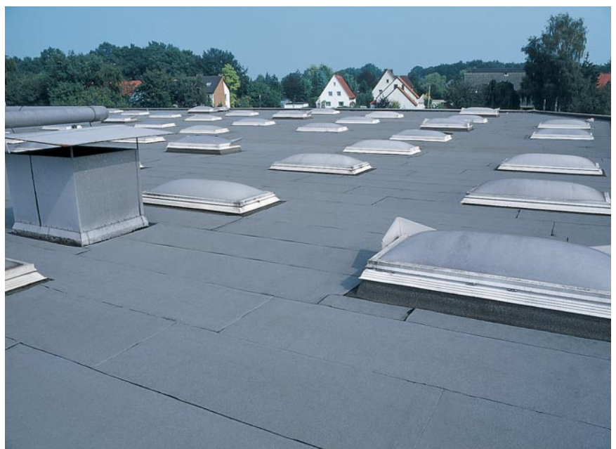
Sanierung auf dem Altaufbau ohne Wärmedämmung – nachher
