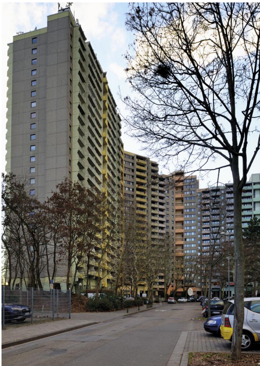
Die Elsa in Mainz-Gonsenheim gilt sie als größte zusammenhängende Wohnanlage in Rheinland-Pfalz. Elco lieferte die neue Heizzentrale.
