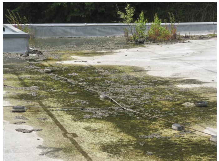
Schmutzablagerungen führen zu erhöhten chemisch-biologischen Belastungen
