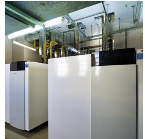
Im Dachgeschoss der Mainzer Wohnanlage sind gleich zwei Trigon XXL EVO 1100 im Einsatz. Die Gas-Brennwertkessel erbringen insgesamt eine Nennwärmeleistung von 2200 kW bei maximal 50/30 Grad.
