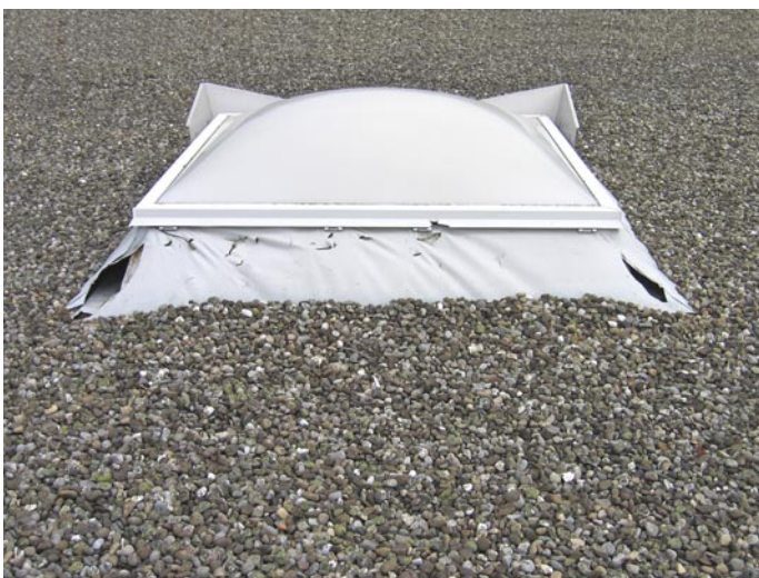
Dachbahn an der Lichtkuppel aufgerissen
