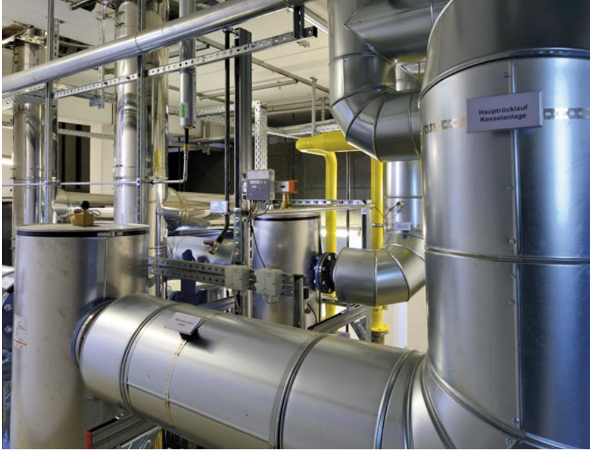
Der der Trigon ist problemlos an alle gängigen Leitsysteme anzubinden, wie zum Beispiel im Falle der Wohnanlage Elsa an BACnet.
