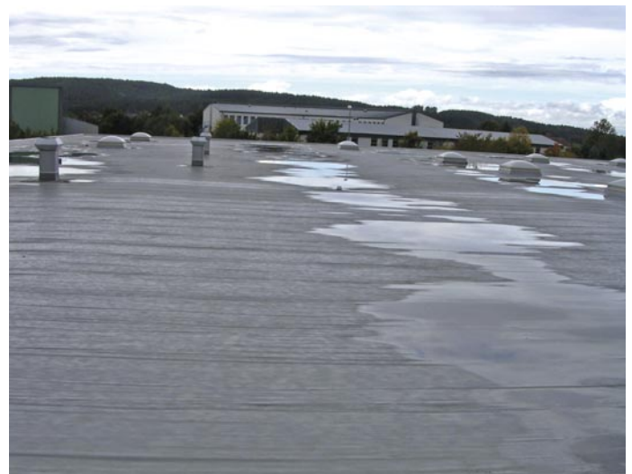
Stehendes Wasser ohne Oberflächenschutz führt zu hohen thermischen Belastungen
