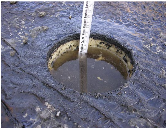
Wärmedämmung extrem durchfeuchtet, Wasser steht auf der Dampfsperre
