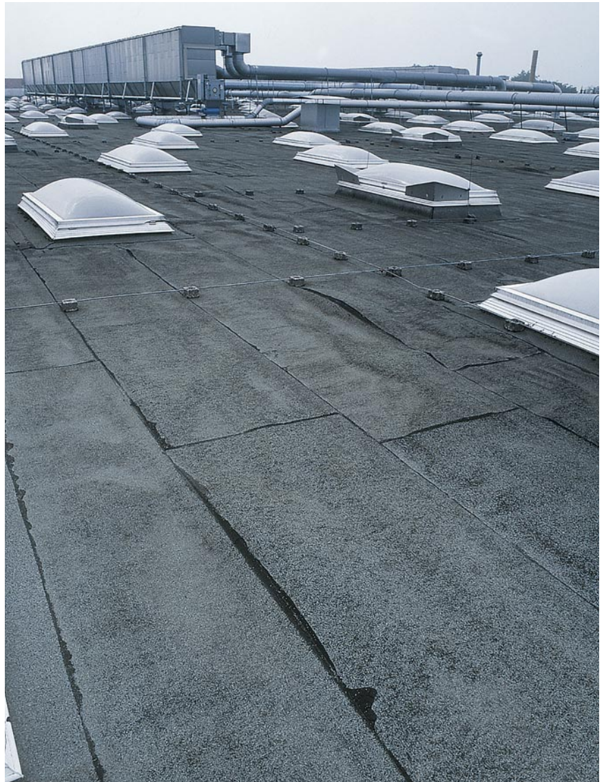
Sanierung auf dem Altaufbau ohne Wärmedämmung – vorher
