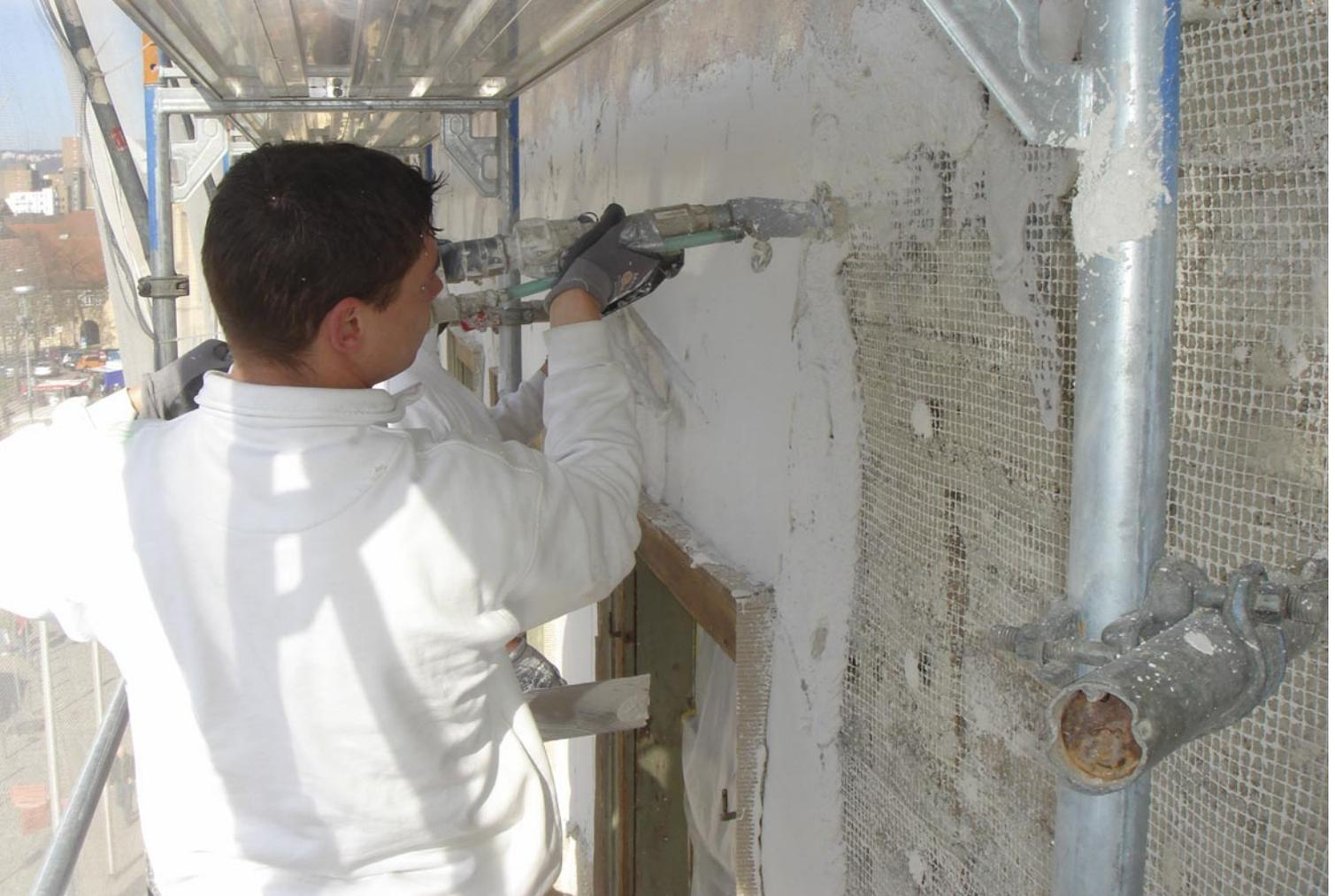
*Der ökologische Dämm- und Entfeuchtungsputz eignet sich für Außen-, Innenwände sowie Kellerwände.*
