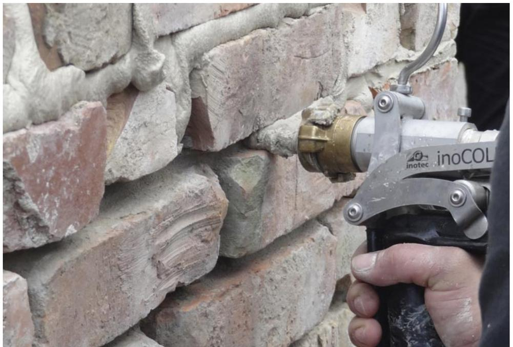
*Der Baustoff eignet sich auch für die maschinelle Verfugung. Diese Methode sorgt unter anderem für Zeitersparnisse und geringe Materialverluste.*
