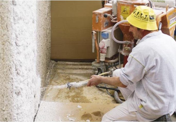
Mit Aufbringen des Naturkalkputzes gegen Feuchte- und Versalzungsschäden mit der Putzmaschine.
