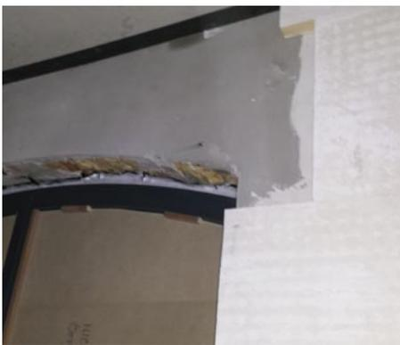
Die Fassaden erhielten eine Innendämmung aus den 50 Millimeter dünnen IQ-Therm Platten.
