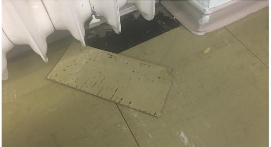
Abbildung 1 zeigt asbesthaltigen PVC-Fußbodenbelag (sogenannte Flex-Platten) mit Anhaftungen von schwarzem Bitumenkleber, der oftmals ebenfalls Asbest enthält.
