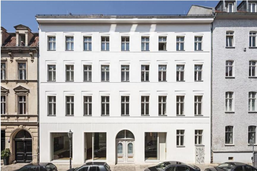
Sanierung einer denkmalgeschützten Gründerzeitfassade mit Dämm- und Entfeuchtungsputz aus Naturkalk.
