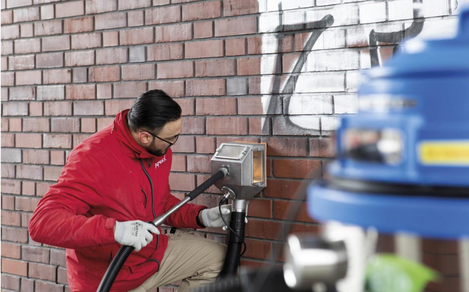
Graffitentfernung mit dem Tornado ACS-Vakuumstrahlverfahren, Foto: systeco
