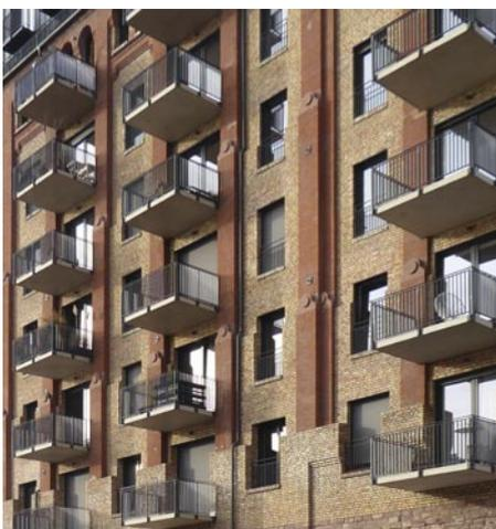
Sockel aus Sandstein, Lisenen aus rotem und Wandfüllungen aus gelbem Backstein: Das Sichtmauerwerk wurde erhalten und von innen gedämmt.
