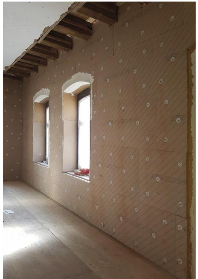
Durch die Stelldübel werden Unebenheiten des Untergrunds von bis zu 2 Zentimetern ausgeglichen.
