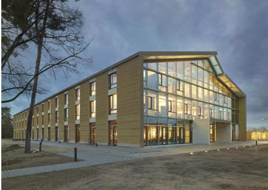
fassade und integrierter geothermischer Wandheizung in Europa. Das alte Baumaterial Lehm prägt dabei sowohl die äußere Gestalt als auch die innere Atmosphäre entscheidend mit und führt zu einer neuen Ästhetik im zeitgemäßen Bürobau. Das Gebäude ist Ergebnis einer gelungenen Zusammenarbeit zwischen dem Bauherrn der Campus 360 GmbH, dem Nutzer Alnatura, den Architekten von Haascookzemmrich –
