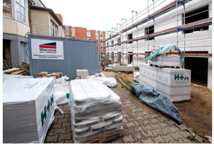
Die Raumtrennwände zwischen den einzelnen Pflegezimmern wurden zugunsten von Brand- und Schallschutz aus Kalksandstein gemauert. Lediglich zum Einbau der Nasszelle kamen gipsbasierte Ausbauplatten zum Einsatz.
