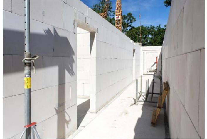
Das Bauunternehmen setzt auch in Dannenberg auf die bewährte Kombination aus Porenbeton für die Außenwand und Kalksandstein für die Innenwände.
