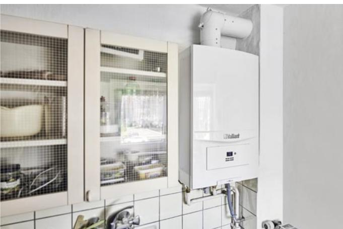
*Passgenau: Die im Rahmen der Sanierung installierten Gas-Brennwertgeräte von Vaillant sind so konzipiert, dass sämtliche Anschlüsse der Altgeräte fast unverändert übernommen werden.*
