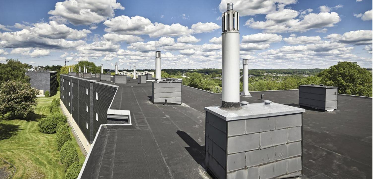
Durch die Umrüstung auf Brennwerttechnik war in den Objekten auch eine Kaminsanierung notwendig, die vom Dach aus über ein zertifiziertes Edelstahlsystem erfolgte.
