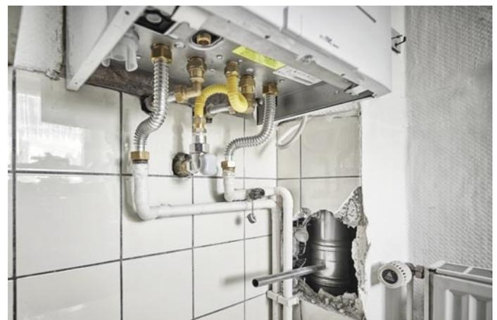
*Für die neuen Anlagen muss lediglich die Abgasdurchführung in den Kamin vergrößert sowie für die Kondensatableitung ein zweiter Durchbruch in den Schacht geschaffen werden.*
