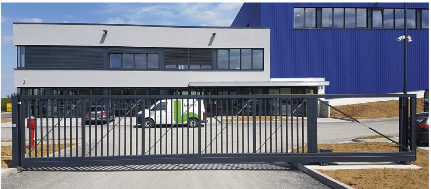
Das Staketten-Systemtor findet sich hierzulande vor vielen Industrieanlagen. Ein Rollladen-Hersteller aus Bodelshausen sicherte seinen Einfahrtsbereich ebenfalls mit dem stabilen Aluminium-Tor, das passgenau auf die gewünschten Anforderungen vor Ort (lichte Durchfahrt 7,5 Meter, Höhe 2 Meter) angefertigt wurde. Bewegt wird das 325 Kilogramm schwere Tor dabei von einem 24-V-Gleichstrommotor.
