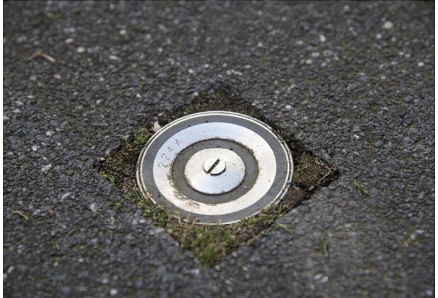
*Der flächenbündig im Asphalt eingebaute Feuchte- und Temperaturfühler kommuniziert permanent mit dem Eismelder, der die Freiflächenheizung erst dann und nur solange einschaltet, wie es die Witterung erfordert.*
