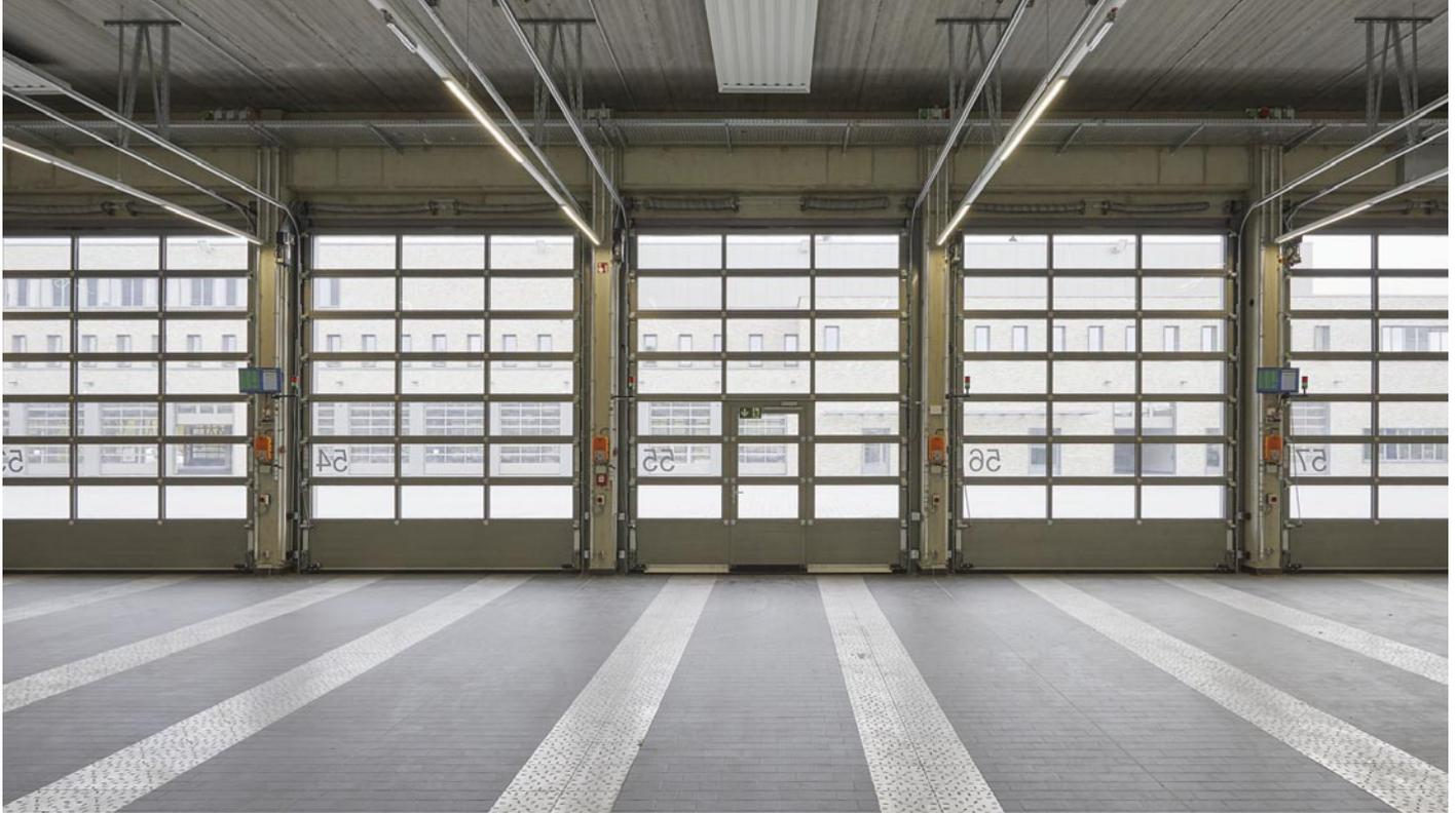
Die voll verglasten Tore sorgen tagsüber für maximalen Lichteinfall im Gebäudeinneren, was eine zusätzliche Beleuchtung erspart.
