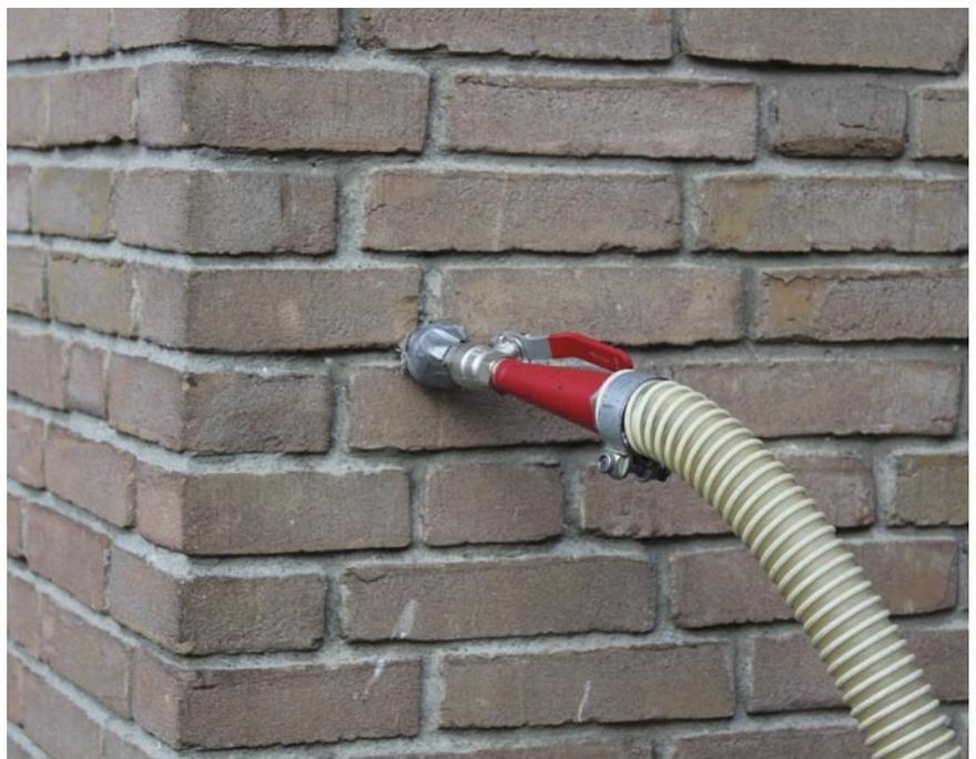
Für die Verarbeitung der Dämmung können alle gängigen Einblasmachinen verwendet werden.
