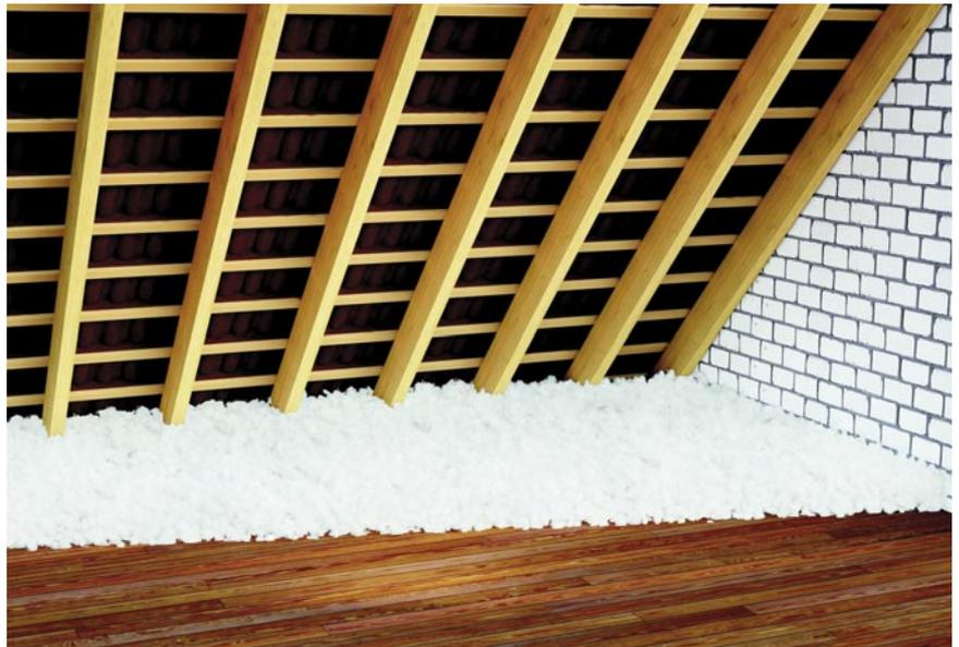
Als Pure Floc kommt die Einblasdämmung auf der obersten Geschossdecke oder im zweischalige Dach zum Einsatz und reduziert hier Wärmeverluste.
