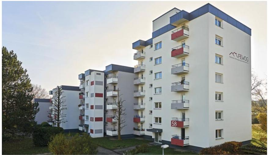
*PU-WDVS benötigen keine Brandriegel. Das vereinfacht die Verarbeitung an geometrisch komplexen Gebäuden erheblich.*
