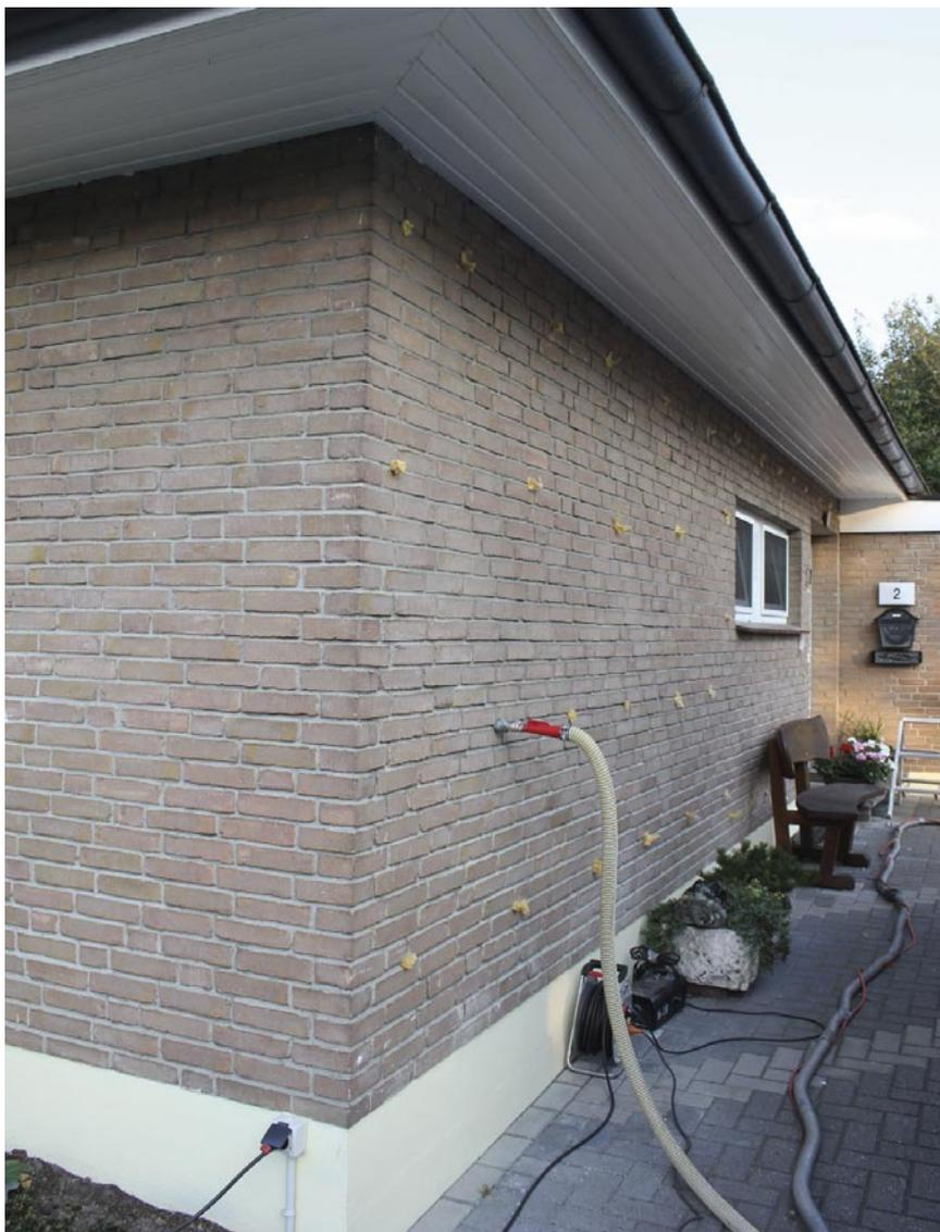
Im zweischaligen Mauerwerk füllt die Einblasdämmung als Pure Floc KD den Hohlraum zwischen Hinter- und Vormauerwerk aus.
