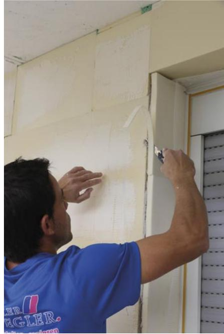
Selbst schlanke Fensterlaibungen sind mit PU gut gedämmt und mit dem Cuttermesser leicht zugeschnitten.
