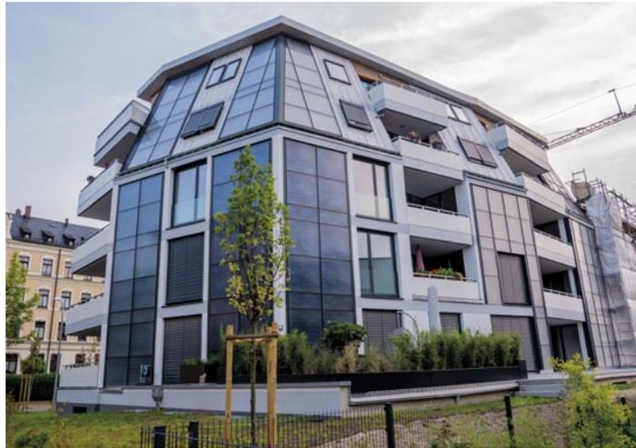
Der erste Bauabschnitt der Eigentumswohnanlage Solardomizil in Chemnitz. 317 Quadratmeter Solarkollektoren für Solardomizil 1 und 2 decken rund die Hälfte des Wärmebedarfs solar.
