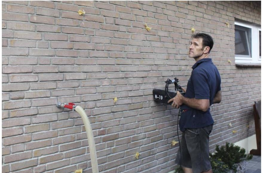
Hohlräume – zum Beispiel in der Außenwand – lassen sich mit der Einblasdämmung fugenfrei und setzungssicher verfüllen.
