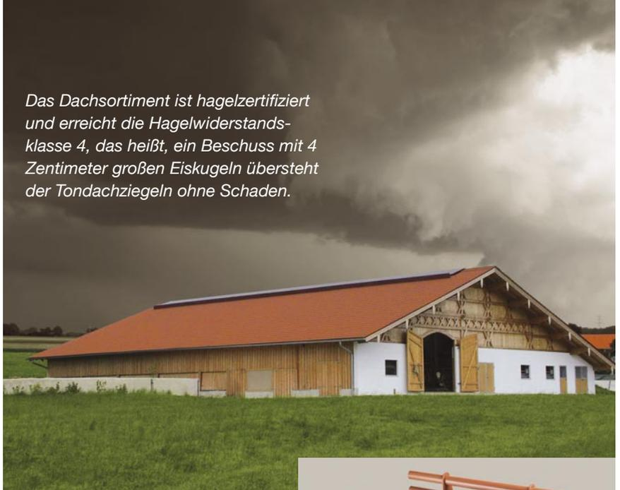
Eine gute Baustoffqualität schützt Immobilien vor Unwetterschäden. Das Institut für Brandschutztechnik und Sicherheitsforschung (IBS) in Linz hat die Hagelresistenz des Erlus Dachsortiments mit einer Hagelsimulationsmaschine getestet. Das Ergebnis: das Tondachziegelsortiment erreicht min-
