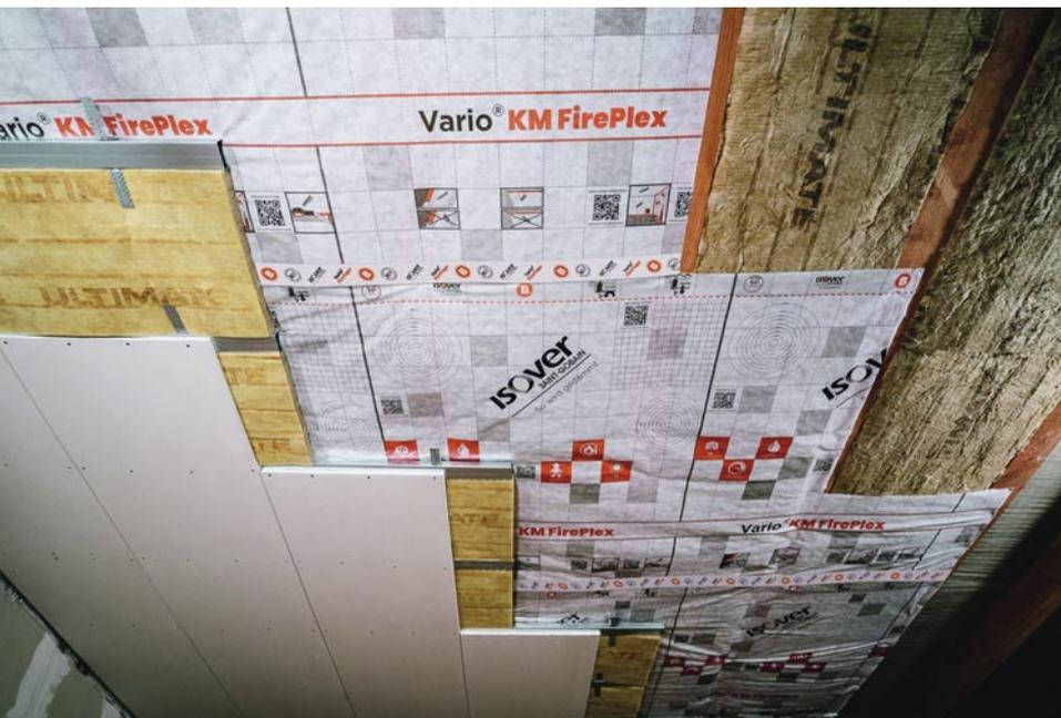
*In Kombination mit nichtbrennbaren Dämmstoffen aus Mineralwolle und der neuen Klimamembran können Konstruktionen geplant und umgesetzt werden, die maximale Brandsicherheit bieten.*
