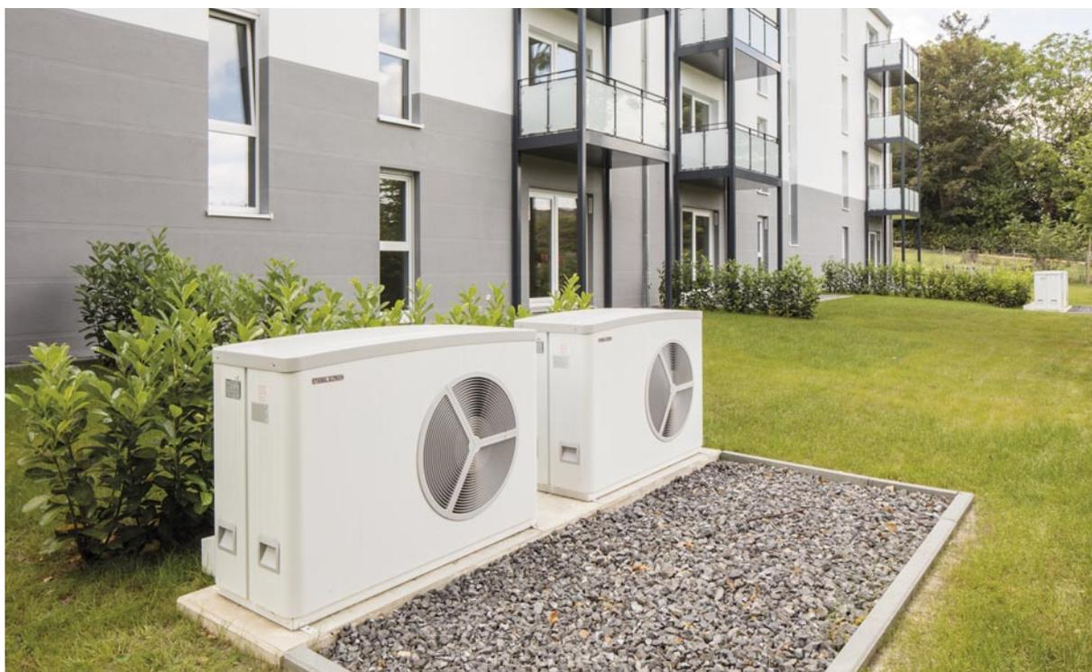
*Perfekte Heiztechnik für den KfW-55-Neubau: Die Luft-Wasser-Wärmepumpe, hier als Kaskade aus zwei Geräten für einen Neun-Wohneinheiten-Neubau.*
