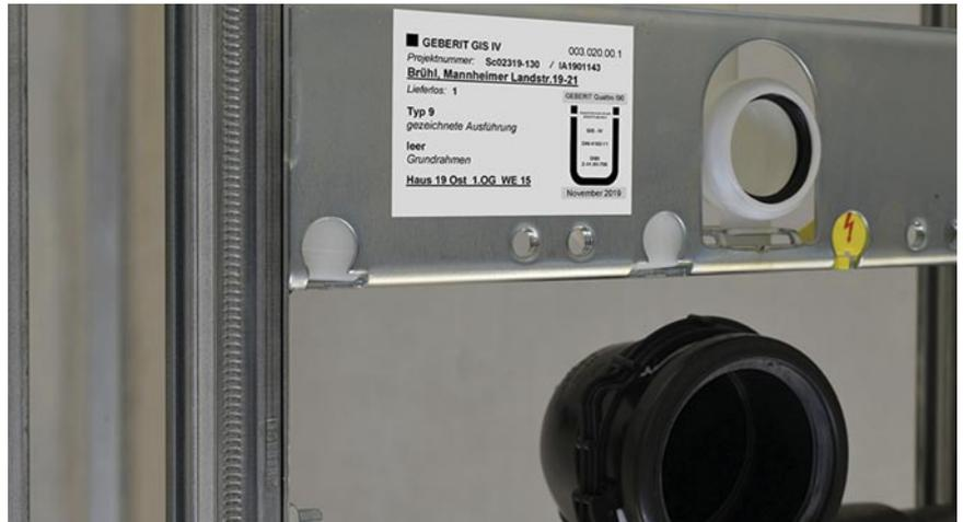
Mit der Ü-Kennzeichnung, wie hier bei einem vorgefertigten Quattro Installationsschacht, gibt der Hersteller seine Übereinstimmungserklärung, durch die in Anwendbarkeitsnachweisen verankerte/abgesicherte industrielle Vorfertigung ab. Zudem wird der Einbauort vorgegeben.
