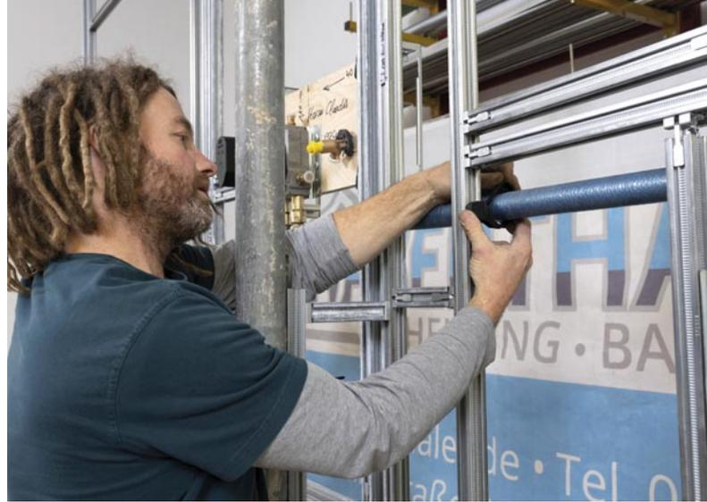
GIS mit handwerklicher Vorfertigung: Das Tragsystem wird auf dem Arbeitstisch zusammenfügen
