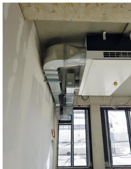
Die Lüftungsgeräte wurden an den Decken der jeweiligen Räumlichkeiten angebracht.
