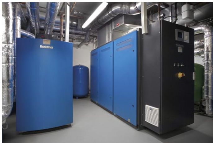
Der Gas-Brennwertkessel Logano plus war mit seiner kompakten Bauart und dem relativ geringen Gewicht ideal für den Einsatz im Hotel Hafenspeicher.
