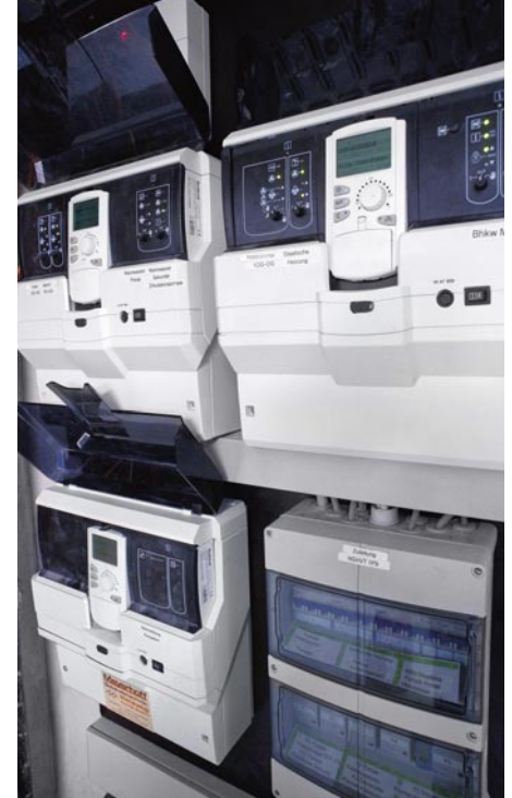
Variabel erweiterbar: Das Regelsystem lässt sich mit unterschiedlichen Funktionsmodulen kombinieren – je nach Anforderung.
