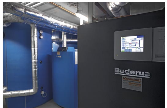
Pufferspeicher, Gas-Brennwertkessel und BHKW spielen im Hotel Hafenspeicher effizient zusammen.
