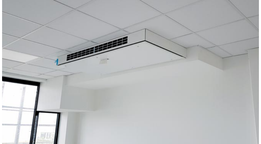
Durch die dezentrale Einbauweise wird jeder Raum ganz individuell mit frischer Luft versorgt.
