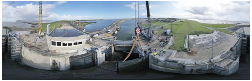
Die Großbaustelle aus der Vogelperspektive: Montage der neuen Stahltore am Sperrwerk Meldorf.
