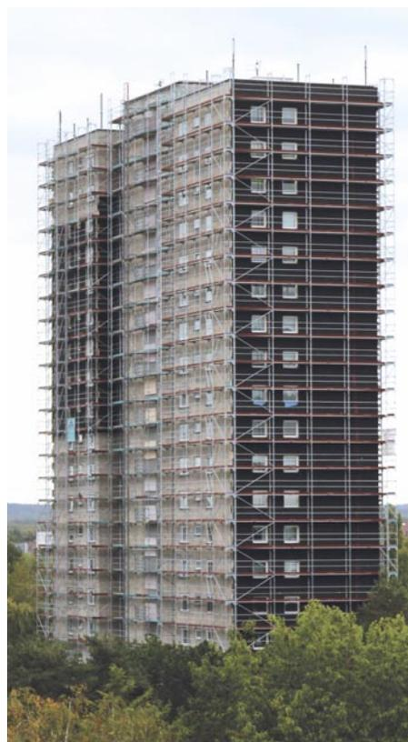
Ende 2018 wurde aus brandschutztechnischen Gründen die gesamte Fassadenverkleidung der fünf Hochhäuser entfernt.
