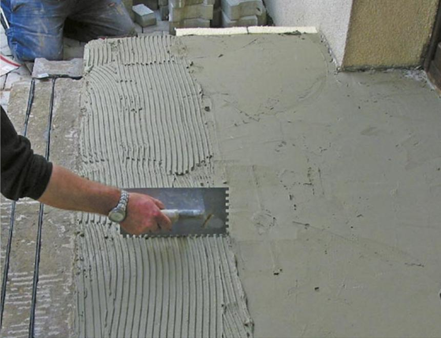
Der Einbau der Heizleiter erfolgt zwischen der untersten Betonschicht der Treppe und dem Schutzestrich beziehungsweise Mörtel auf den Stufen unterhalb des Treppeneroberbelags.
