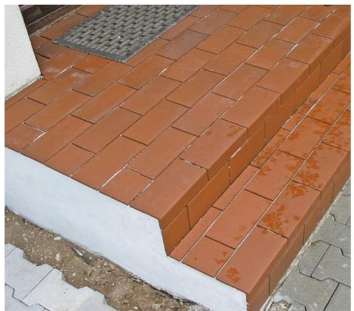
Sobald die Außentemperatur sinkt und Frostgefahr droht, schaltet sich die Treppenheizung automatisch ein, so dass sich weder eine Schneeauflage noch eine Eisschicht bilden kann.
