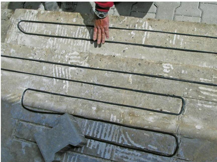
In den seitlichen Bereichen der Verschleifung stemmt der Fachmann die Biegeradien mit einem Meißel aus, da das Heizkabel innerhalb der Nut nicht über scharfe Kanten geführt oder gequetscht werden darf.
