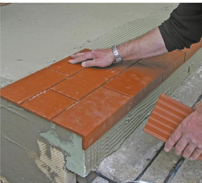
Bei der Wahl des Treppenbelags gilt: Je geringer die Überdeckung der Heizleiter, desto kürzer ist die Aufheizzeit des Systems. Eine Überdeckung von mehr als 8 Zentimetern ist nicht zu empfehlen.
