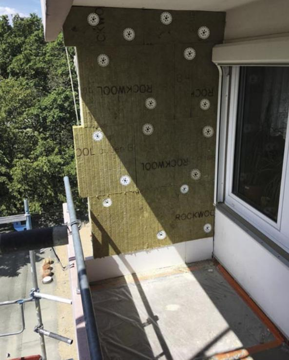
Die Seitenwände von 390 Balkonnischen wurden von der Firma Aksu Stuck aus Fürth mit dem brandsicheren, rein mineralischen Wärmedämm-Verbundsystem versehen.
