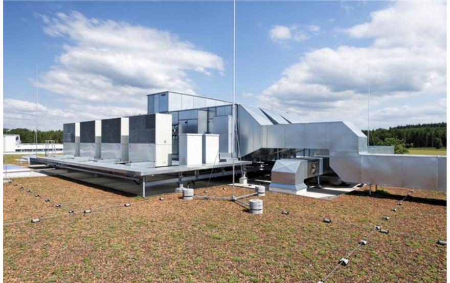
Eine große, effiziente Lüftungsanlage auf dem Dach sorgt für eine konstante Raumtemperatur innerhalb der Produktionshalle.
