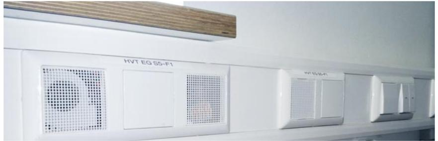
Trotz grundsätzlicher Automatik: Heizung und Lüftung können von Hand direkt aus dem Klassenzimmer gesteuert werden.
