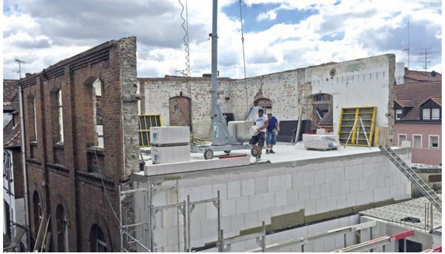
*Der Innenraum hinter der Fassade wurde komplett neu aufgebaut.*
