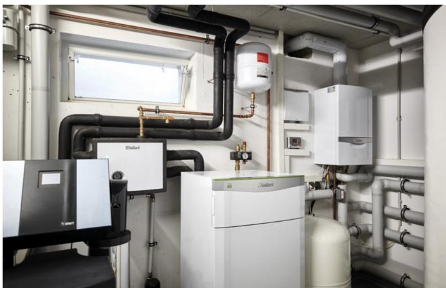
*Eine skalierbare Anlagenkonfiguration, die künftig wohl Standard werden wird: die Luft/Wasser-Wärmepumpe deckt die Wärmegrundlast ab, ein Gas-Brennwertgerät die Spitzenlasten, inklusive hygienischer Warmwasserbereitung.*
