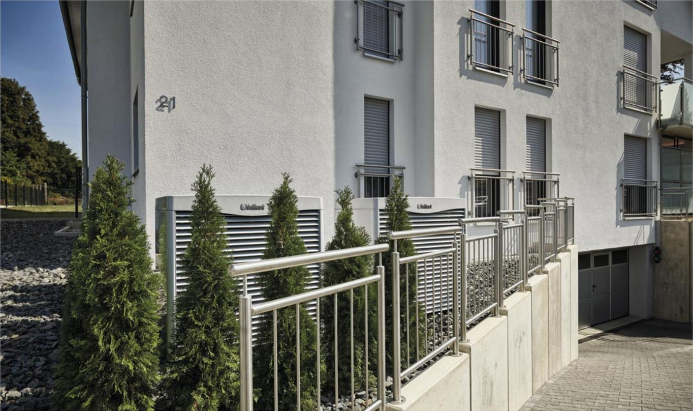
Je nach Wärmebedarf ziehen die Luft/Wasser-Wärmepumpen die regenerative Umweltenergie über ein oder zwei Außeneinheiten. Das unterstützt die Flexibilität der Anlagenkombination zusätzlich.
