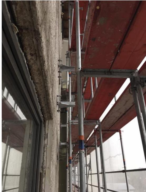
*Knifflige Aufgabe: Die Unterkonstruktion musste eine Schrägstellung ausgleichen und durfte die vorgehängten Betonfertigteile nicht belasten.*
