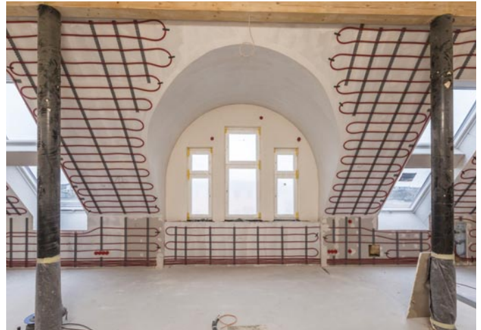
Auf die mit Rotkalk Grund egalisierte Wand wird das Innendämmsystem Knauf Rotkalk In-Board aus diffusionsoffenem Perlitgestein vollflächig verklebt. – Foto rechts: An den Steildachflächen der beiden neu ausgebauten Dachgeschosswohnungen wurde eine Wandheizung eingebaut. Die Heizstränge werden an Befestigungsschienen fixiert. Die Flächen darunter wurden zusätzlich mit Gipskartonplatten verstärkt und mit Sperrgrund abgedichtet.
