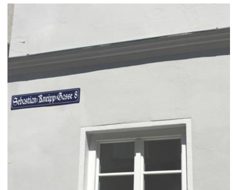
Der Anstrich mit Soldalit-Arte unterstreicht die Originalstruktur und die Mentalität des Untergrundes.
