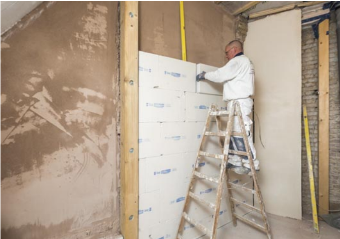
Auf die mit Rotkalk Grund egalisierte Wand wird das Innendämmsystem Knauf Rotkalk In-Board aus diffusionsoffenem Perlitgestein vollflächig verklebt. – Foto rechts: An den Steildachflächen der beiden neu ausgebauten Dachgeschosswohnungen wurde eine Wandheizung eingebaut. Die Heizstränge werden an Befestigungsschienen fixiert. Die Flächen darunter wurden zusätzlich mit Gipskartonplatten verstärkt und mit Sperrgrund abgedichtet.
