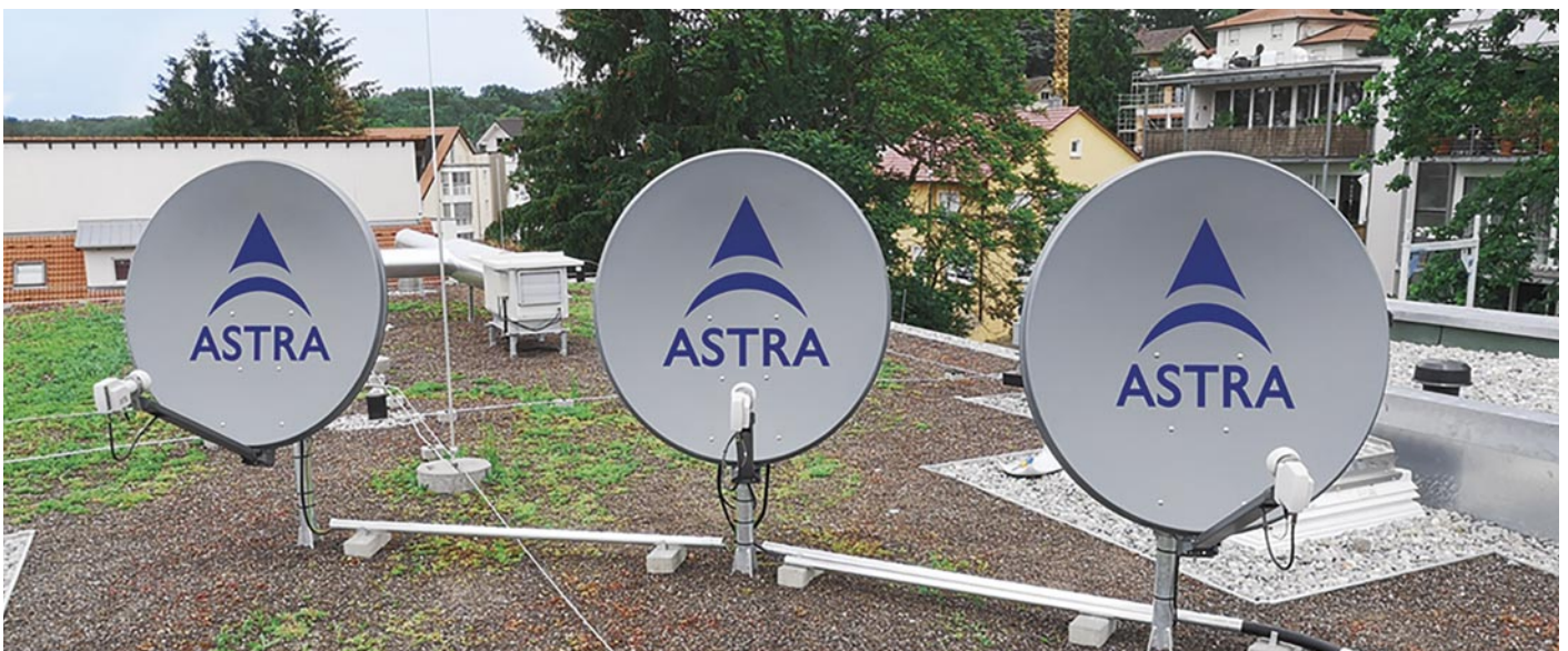
Die Kombination aus Glasfaser und SAT-Anlage erlaubt den verlustfreien Transport des Satellitensignals über weite Strecken. So ist auch die Versorgung wesentlich größerer oder höherer Wohnanlagen problemlos möglich.
