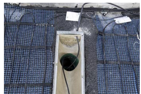
Damit das Tauwasser frei abfließen kann, wird das Heizkabel etwa einen Meter tief in das Ablaufrohr geführt.
