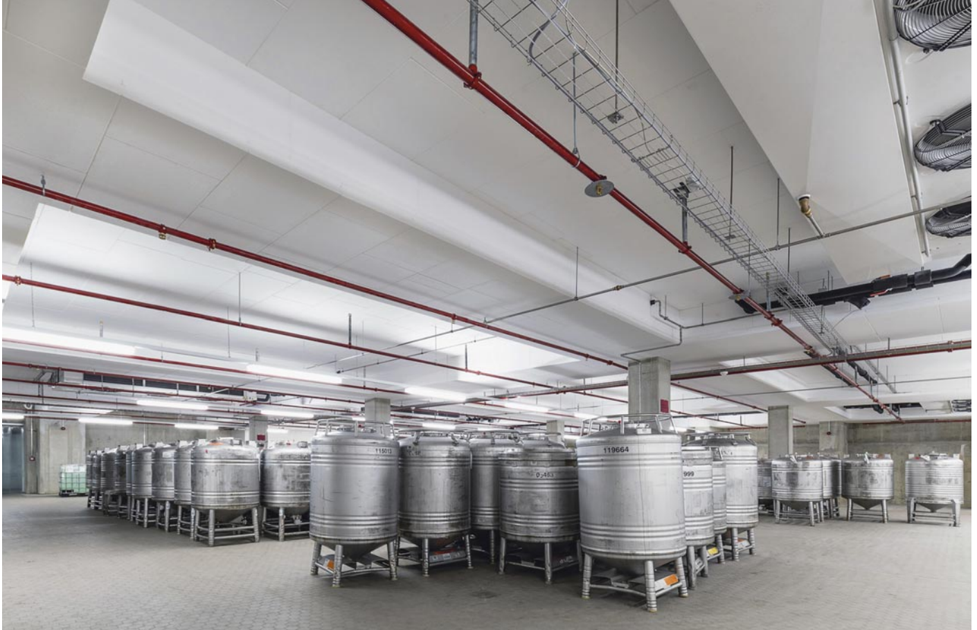
Im Fruchtkeller von Ehrmann werden Container mit hochwertigen Fruchtzubereitungen für Joghurts und andere Milchprodukte gelagert. Für Top-Kälte­dämmung sorgt dort die Kellerdecke Styro von JOMA.
