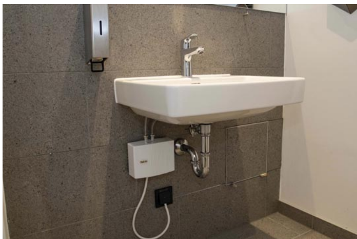
Der elektronische Kleindurchlauferhitzer zeichnet sich durch ein verkalkungsunempfindliches, effektives Blankdrahtsystem für sekundenschnelle Aufheizung bis zum Leistungslimit aus.
