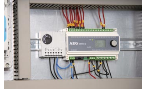
Einstellparameter wie Einschalttemperatur, Feuchteempfindlichkeit und Nachlaufzeit lassen sich über das LC-Display des Eismelders festlegen, wodurch Betriebsanpassungen von „ökonomisch“ bis „sehr sicher“ möglich sind.
