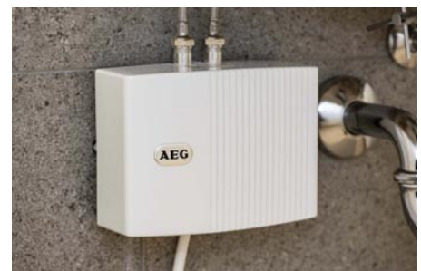
Der elektronische Kleindurchlauferhitzer zeichnet sich durch ein verkalkungsunempfindliches, effektives Blankdrahtsystem für sekundenschnelle Aufheizung bis zum Leistungslimit aus.
