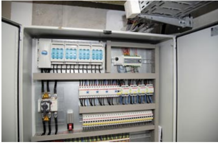
Der Zweizonen-Eismelder befindet sich im Verteilerschrank in der Tiefgarage, wo er zuverlässig die feuchte- und temperaturabhängige Regelung übernimmt.
