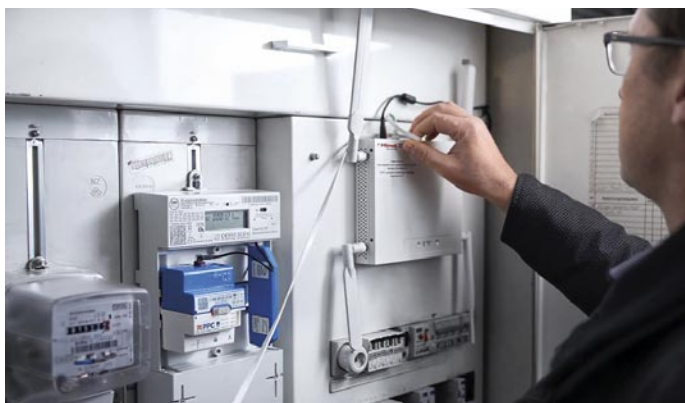
Die messtechnische Lösung ImmoDigital+ in einem Wohnhaus in Leinfelden-Echterdingen.
