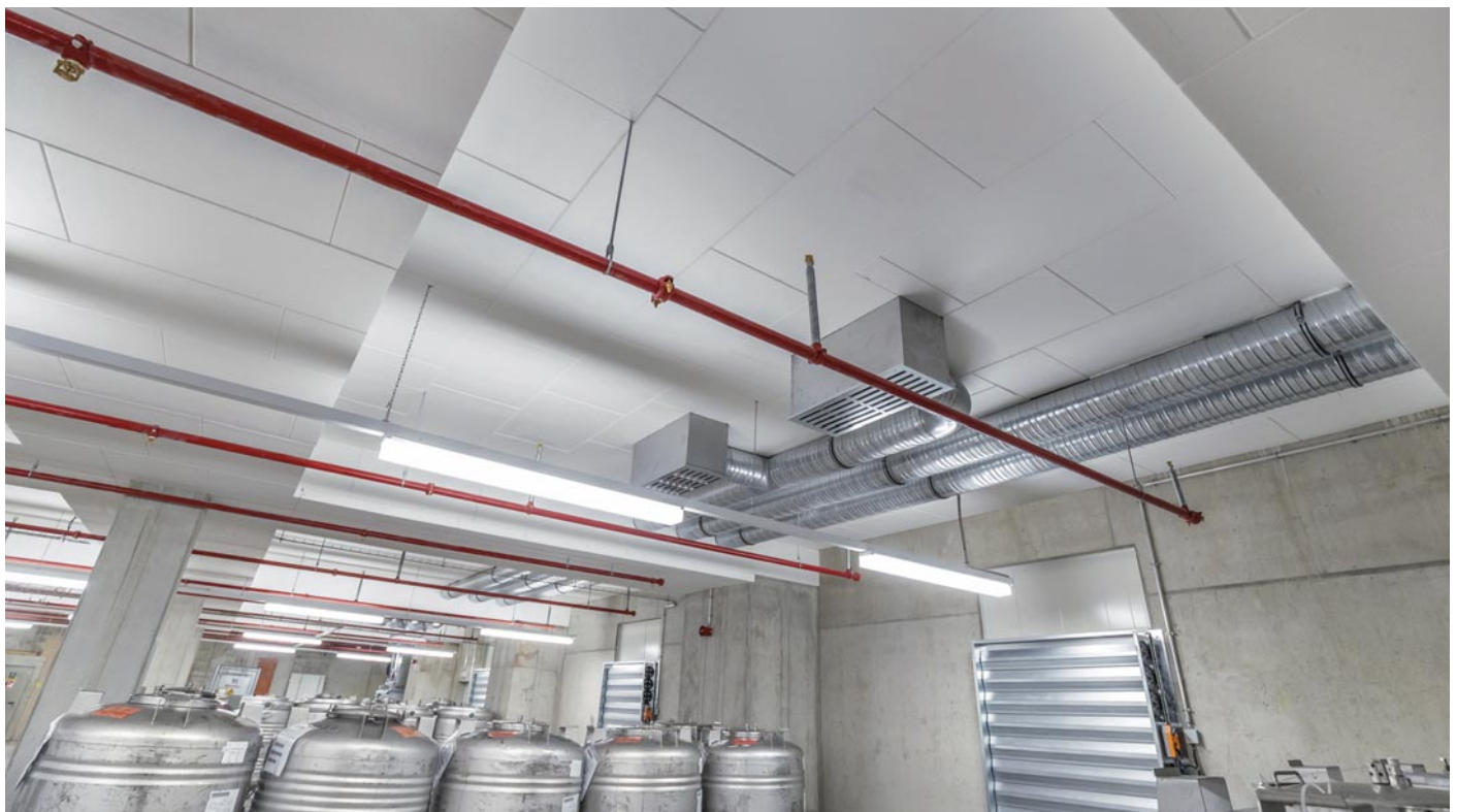
Die Kellerdecke Styro von JOMA sorgt im neuen Fruchtkeller von Ehrmann für Top-Kälte­dämmung. Sie lässt sich wärmebrückenfrei und dank eines innovativen Schienenstücksystems auch ganz ohne Druckstellen montieren.
