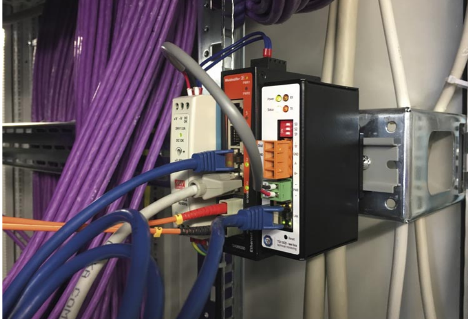
Bild 2: Technisches Monitoring (TMon) mit der test box vor Ort
