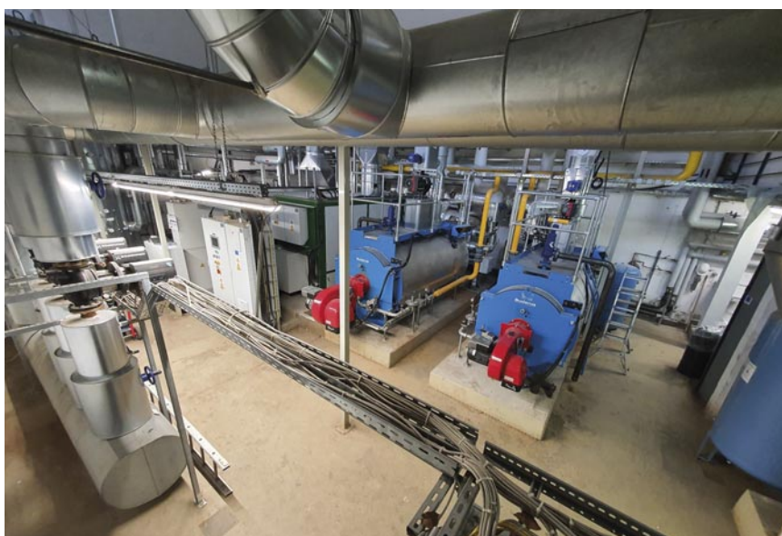
Ein Blick auf zwei Blockheizkraftwerke, die die Energiezentrale Nord optimiert.
