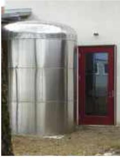
Heizungswasser-Pufferspeicher als oberirdisch aufgestellter Außenbehälter mit 200 Millimeter Mineralwolldämmung, 8000 Liter Fassungsvermögen.
