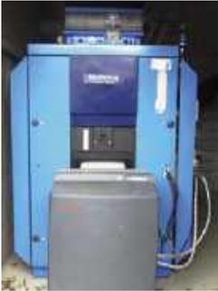
Für Redundanz und Spitzenlast ist ein Buderus-Ölkessel mit 240 kW installiert, versorgt aus einem schon vorhandenen Heizöllager.
