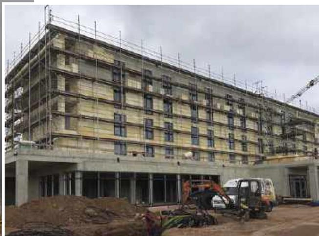
Rund 3000 Quadratmeter Fassadenfläche wurden mit PU-Dämmstoffen gedämmt.
