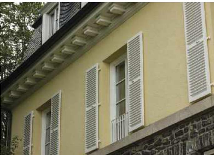
Die Arbeiten an 5000 Quadratmeter Fassade nahmen mehr als zwei Jahre in Anspruch. Abschließend strichen die Handwerker den Putz zweimal mit Keim Soldalit in Ockergelb.
