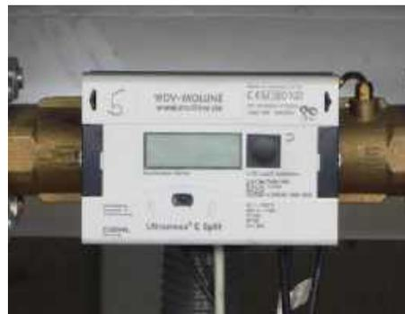
Wärmezähler, mit dem der Contractor die gelieferte Wärmemenge feststellen und den belieferten Firmen berechnen kann.
