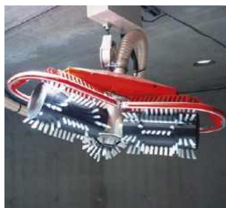
*Programmgesteuertes Holzpellet-Entnahmesystem „Maulwurf“, hier vor der Befüllung unter der Decke des Speichers arretiert.*
