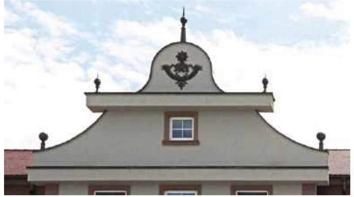
Die spektakulärsten Fertigbauteile des Herrenhauses – die Schweifbogen-Giebel. Die Schalung wurde mit einer hochmodernen CNC-Fräsmaschine millimetergenau hergestellt.
