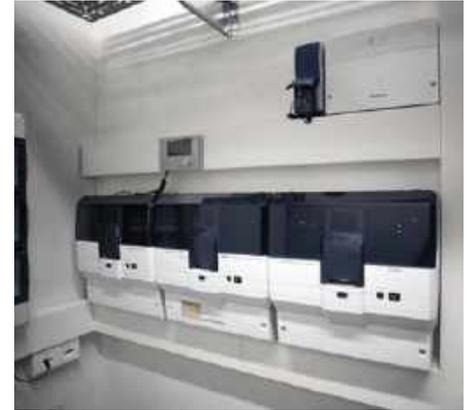
Die digitalen Regelgeräte Logamatic 4121 und 4122 bieten Platz für Funktionsmodule für unterschiedliche Anwendungen.
