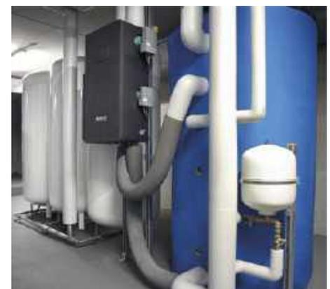
Sauber installiert: BHKW- und System-Pufferspeicher (links) und Warmwasserspeicher SF 1000/5 mit dem Speicherladesystem Logalux SLP5 (rechts).
