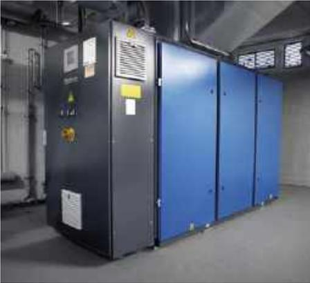
Das Blockheizkraftwerk Loganova EN 50 des Systemexperten Buderus deckt die Grundlast des Strom- und Wärmebedarfs im Hotel.
