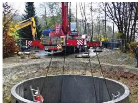
*Versetzen des unterirdischen Pelletspeichers aus Betonfertigteilen, Fassungsvermögen 45 Kubikmeter, mit bauseitigem Autokran.*
