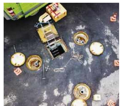
*Pelletspeicher fertig installiert, vor der Befüllung. Blick auf die geöffneten drei Befüllöffnungen und den rechteckigen Einstieg.*
