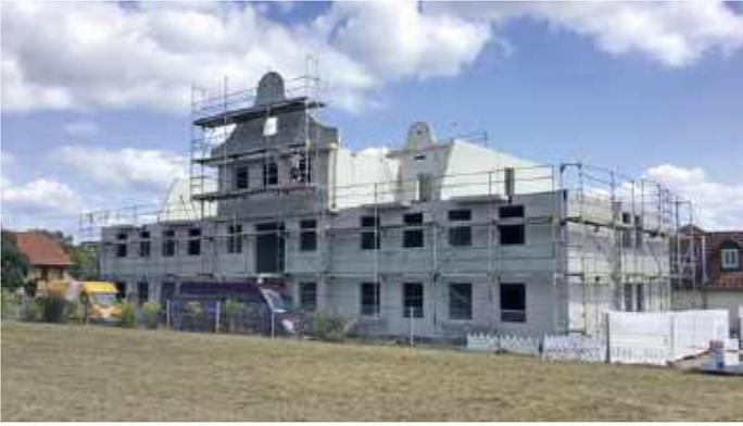
Für den Bau des Herrenhauses wurden Wandelemente, Decken, Treppen, Segmentbogenstürze und sogar die Schweifbogen-Giebel vorgefertigt.
