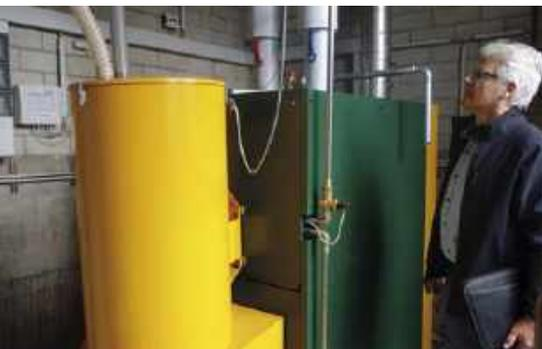
Holzpellet-Kessel (grün), der zwischen 40,5 kW und 135 kW modulierend läuft. Im Vordergrund Vorratsbehälter mit Saugturbine des Entnahmesystems (gelb).
