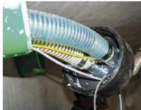
Saugschlauch (weiß) als flexible Kunststoffleitung mit 50 Millimeter Durchmesser unter der Decke des Speichers installiert, daneben Rückluftschlauch (blau).
