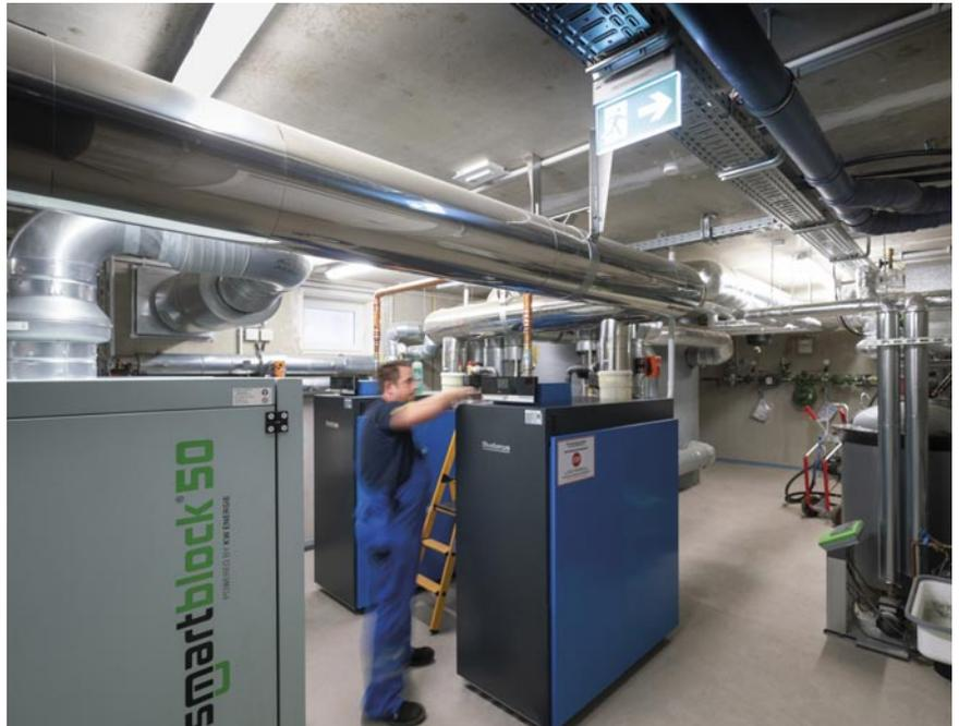
*Für die Energieversorgung des Quartiers am Wald in Worpswede hat EWE eine Kombination aus Gasbrennwertsystem und hocheffizienter Kraft-Wärme-Kopplungsanlage für die gleichzeitige Strom- und Wärmeproduktion gebaut.*
