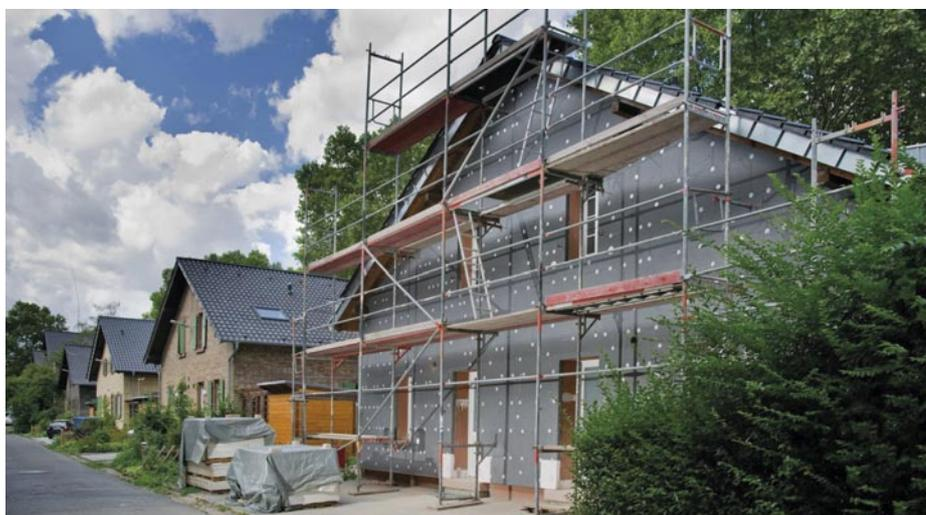
Eine Fassadendämmung mit EPS ist äußerst langlebig.
