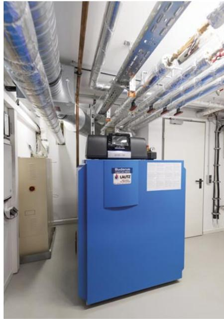
Mit 160 kW Leistung deckt der Buderus Gas-Brennwertkessel Logano plus GB312 die Spitzenlast.
