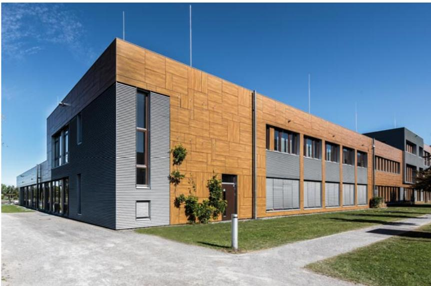
*Bei dem Großprojekt wurden zirka 30.000 Quadratmeter Holzdekor-Folie an der Fassade angebracht.*
