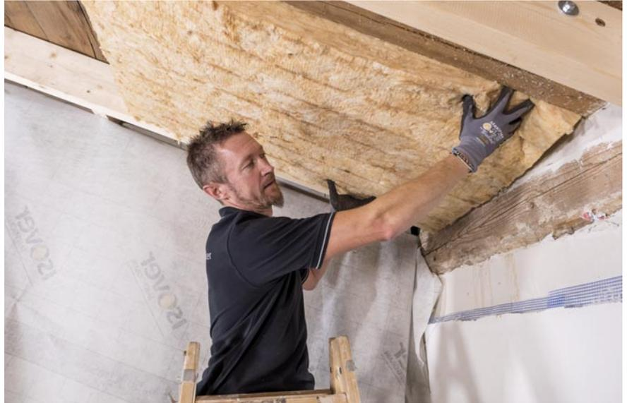
Zur Verlegung einer, nichtbrennbaren Zwischensparrendämmung, die später von einer zusätzlichen Untersparrendämmung ergänzt werden sollte, mussten die Sparren lediglich mit einer Aufdopplung von 60 auf die erforderlichen 180 Millimeter gebracht werden.
