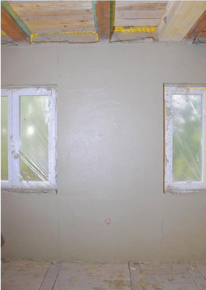
Der Dämmputz kommt ganz ohne Chemiezusatz und mit einer geringen Schichtdicke aus. Das prädestiniert die Innovation für einen Einsatz im Bereich der Innendämmung.
