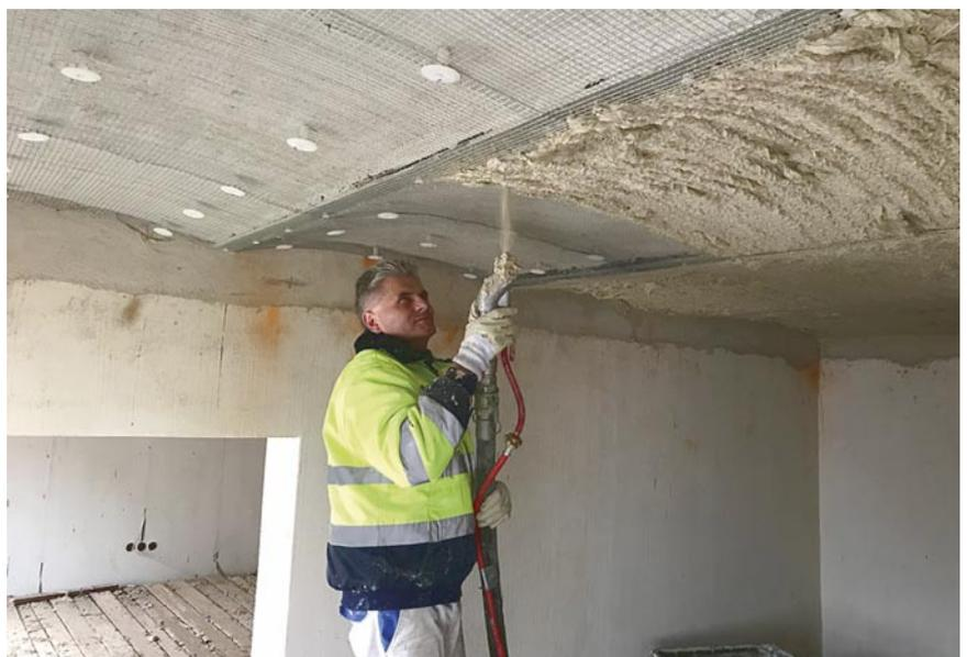
*Die Ecosphere-Spritzdämmung passt sich jedem Untergrund problemlos an. So ist ein lücken- und fugenloses Ergebnis selbst bei der Altbausanierung gewährleistet.*
