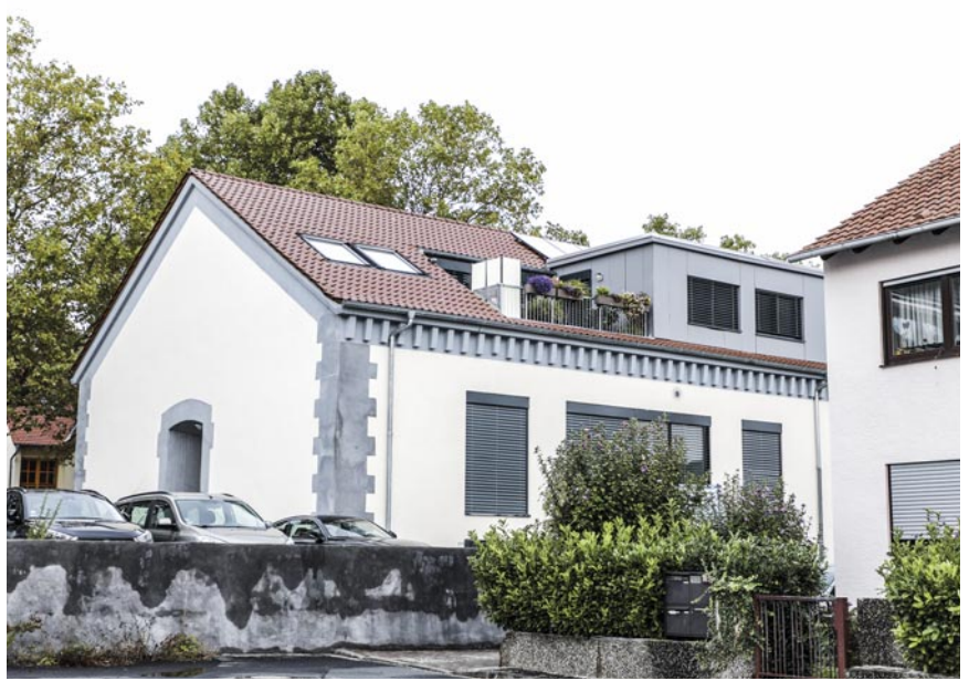
Früher Luftschutzbunker, heute Mehrfamilienhaus mit acht Eigentumswohnungen – das modernisierte Gebäude in Offenbach.
