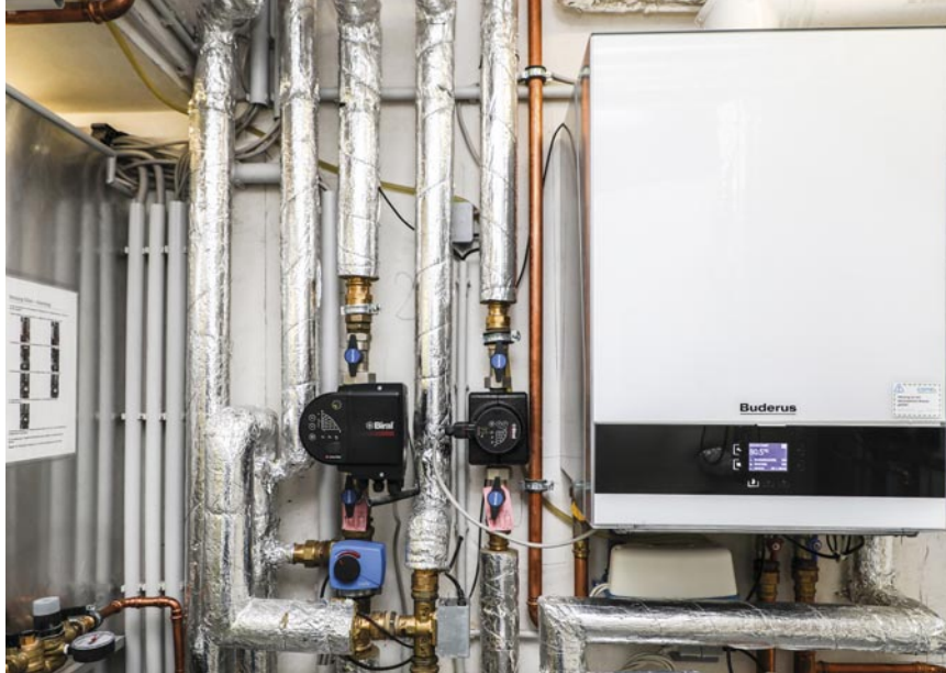
Das wandhängende Gas-Brennwertgerät Logamax bringt hohe Leistung auf sehr kompaktem Raum.
