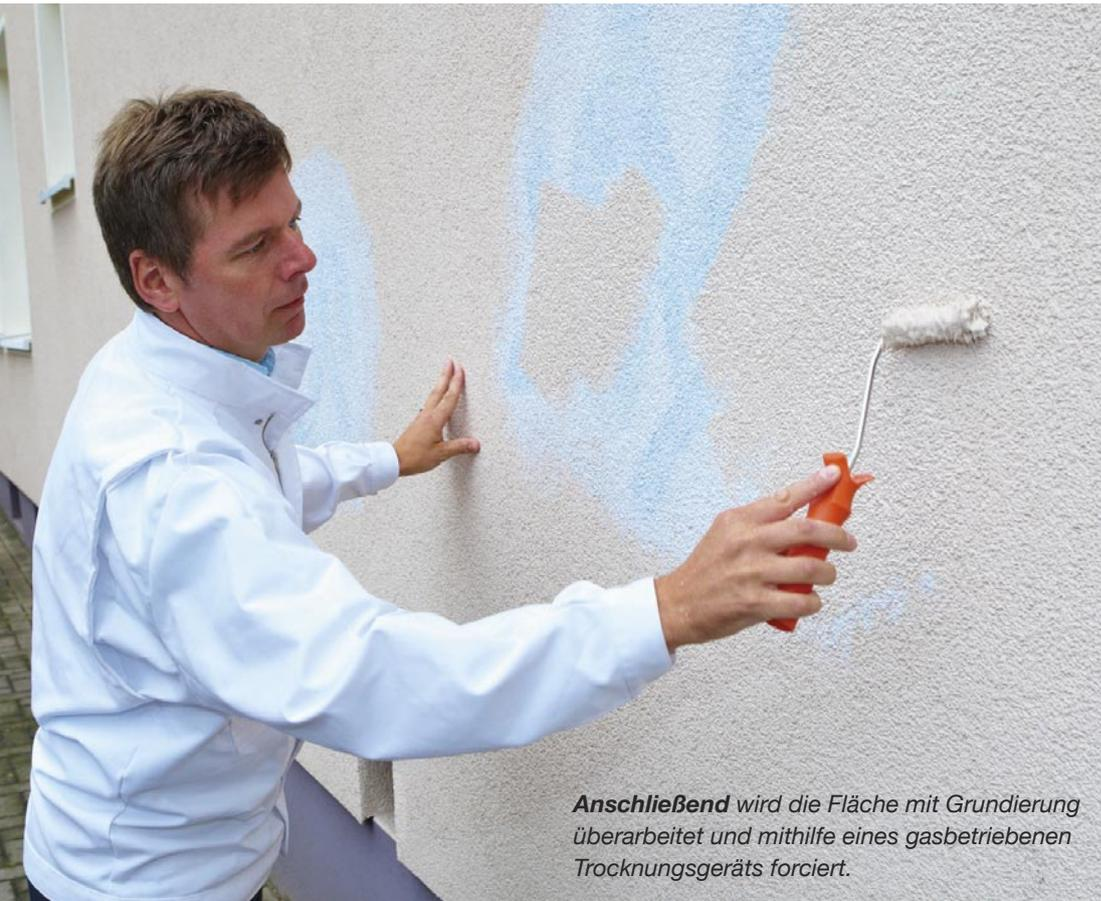
*Anschließend wird die Fläche mit Grundierung überarbeitet und mithilfe eines gasbetriebenen Trocknungsgeräts forciert.*
