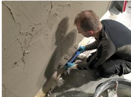
hoher Feuchtebelastung und basiert ebenfalls auf der hydrophobierenden Grundierung Kiesol. Hinzu kommen salzresistente Schlämme und als Kondensatpuffer der weiße Sanierputz SP Top White. Dieser Spezialputz für feuchte- und salzbelastetes Mauerwerk kann als Unter- und Oberputz eingesetzt werden. Eine besonders innovative Art der
