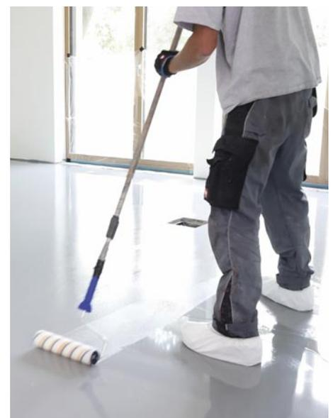
Entfernen von Staub und Schmutz vor dem Versiegeln der Fläche. Anschließend Aufziehen vom PUR Top M Plus mittels PU-Rolle.
