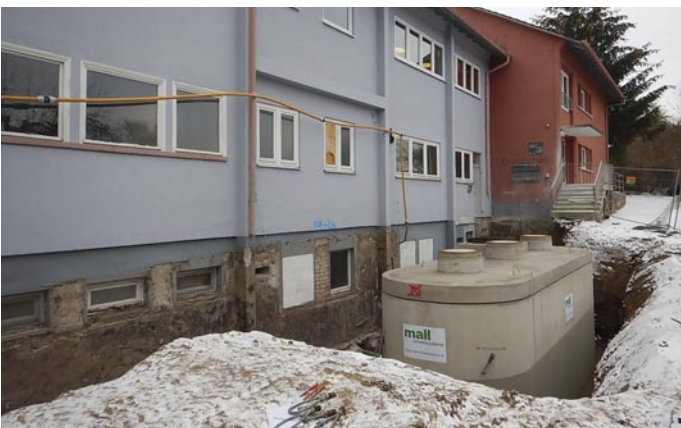
Schlossberghalle Niedereschach. Einbau des neuen Pellettspeichers unter beengten Verhältnissen auf der Nordseite. Der Fertigteil-Ovalbehälter wurde per Autokran direkt vom Lieferfahrzeug an die Stelle des früheren Öltanks gesetzt.
