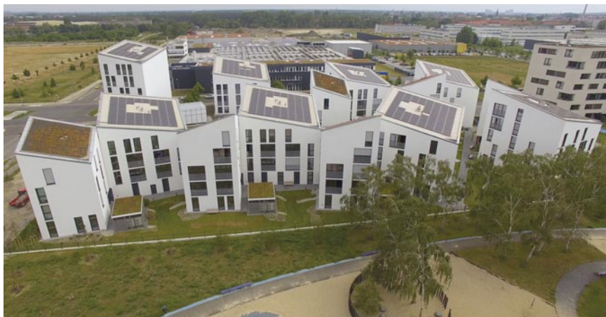
Das neue Smart City-Quartier Future Living Berlin kombiniert nachhaltiges und digital-vernetztes Leben. Im Mittelpunkt des regenerativen Energiekonzeptes stehen die Luft-Wasser-Wärmepumpen und Photovoltaik-Module.
