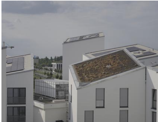
600 PV-Module mit 195 kWp Gesamtleistung sind auf den Dächern des neuen Quartiers installiert. Sie erzeugen CO 2 -freien Strom für die Luft-Wasser-Wärmepumpen.
