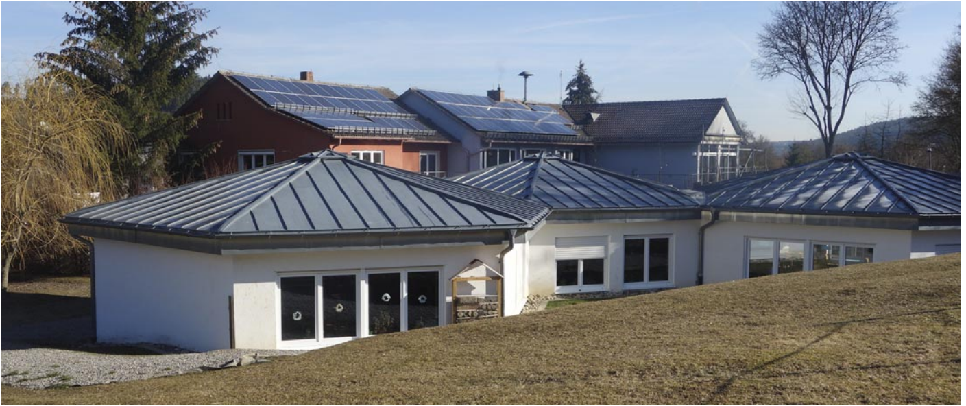
Schlossberghalle Niedereschach. Südseite mit Kindergarten und Grundschule im Vordergrund. Eine Heizzentrale versorgt alle Gebäudeteile, einschließlich Schulsporthalle und Feuerwehrgerätehaus, umgestellt 2019 von Öl auf Holzpellets.
