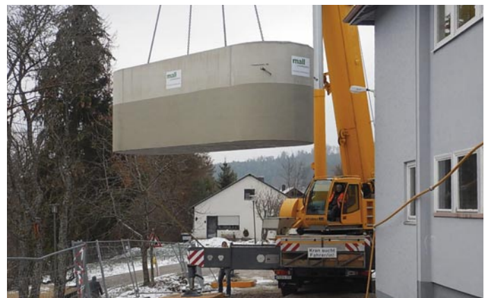
Versetzen des Ovalbehälters vom Lieferfahrzeug in die vorbereitete Baugrube. Er ist 2,60 m hoch und 2,48 m breit, verursacht weder Überbreite noch Übergewicht, kann daher preiswert ohne Sondergenehmigung zum Einbauort befördert werden.
