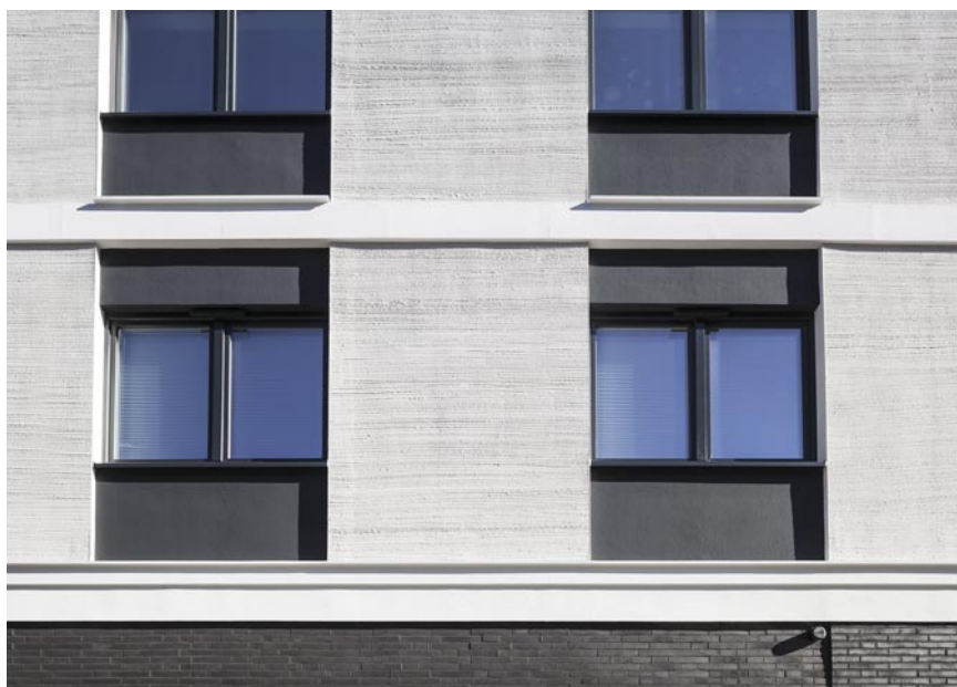
Sanierung eines Mehrfamilienhauses – helle besengestrichene Putzfelder und dunkle gefilzte Putzflächen gliedern die Fassade.
